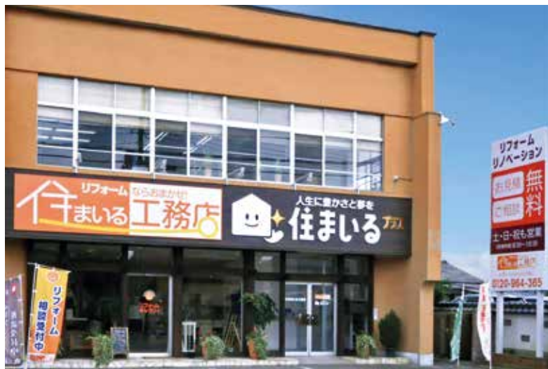
After 完成した正面看板とポール看板
