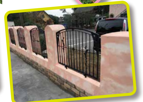
外構（フェンス）施工
