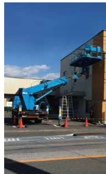
クレーン車を使って施工します
