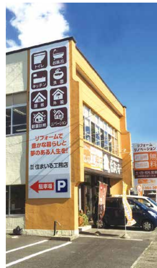
After 完成した西側壁看板
